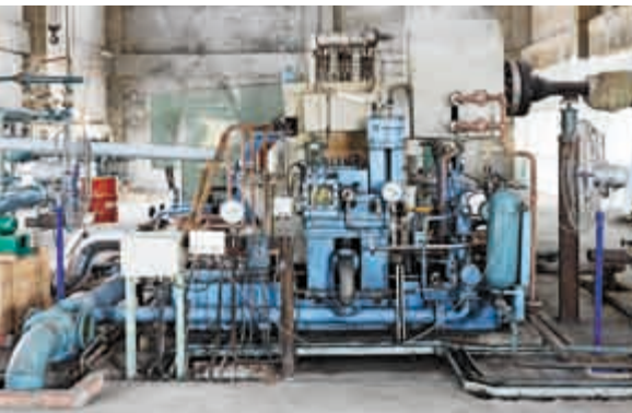
Die 3,66 MW Turbine der Anlage.
