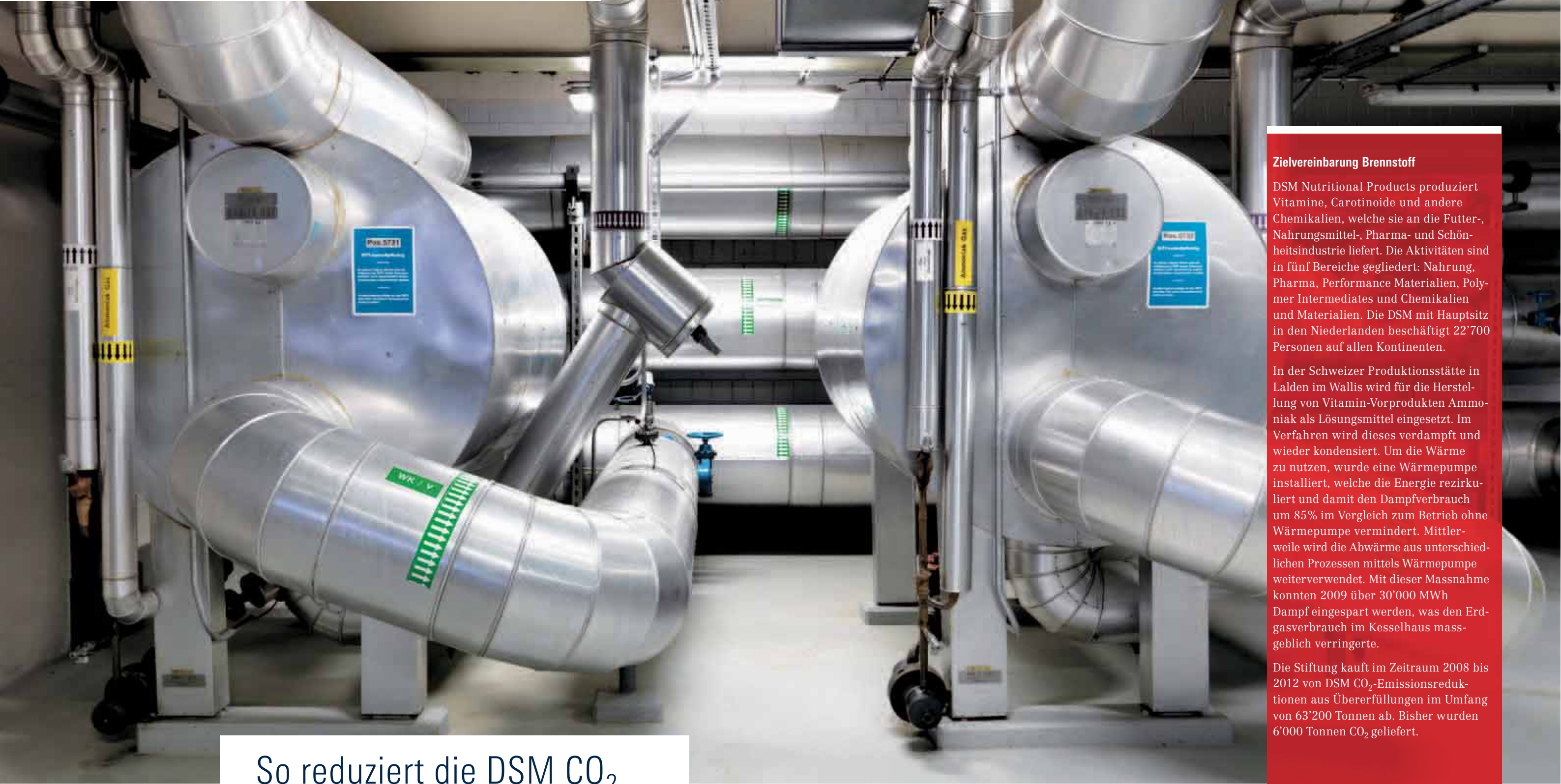
Herz der Wärmepumpe: die drei Ammoniakkompressoren, zu deren Antrieb 500 kW nötig sind.
