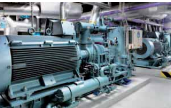
Herz der Wärmepumpe: die drei Ammoniakkompressoren, zu deren Antrieb 500 kW nötig sind.
